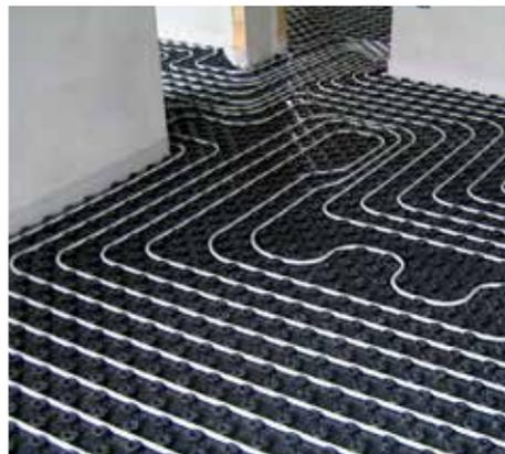
stano in **serpentine di tubi di plastica nascoste nel pavimento, nelle pareti o nei soffitti**. Queste serpentine convogliano acqua a bassa temperatura (32-36°C) che riscalda lentamente le superfici e da qui **distribuiscono il calore nell'ambiente in modo uniforme**. Garantiscono un'ampia superficie di irraggiamento, evitano il formarsi di muffe sulle pareti, inoltre, non ingombrano e, quindi, non limitano la libertà d'arredo, ma consentono l'utilizzo di tutto lo spazio disponibile.
